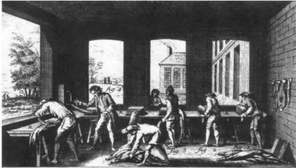
Peigneurs dont les uns peignent le chanvre sur le peigne à dégrossir, et d'autres sur les peignes à affiner. © Photo Illustration Amis du Vieil Arbrèsle
